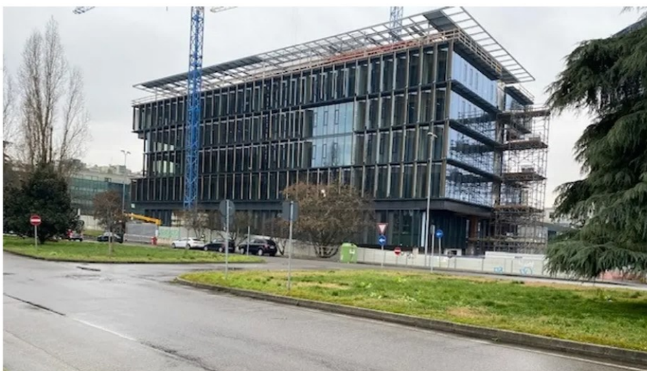
Corre veloce il cantiere Zucchetti tra via Grandi e via Maestri del lavoro
